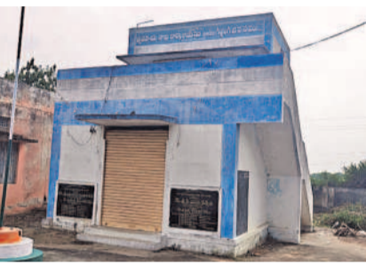
నిరుపయోగంగా ఉన్న అగ్రీకల్చర్ కార్యాలయ భవనం
