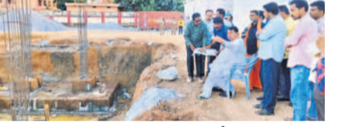
దవాఖాన భవన నిర్మాణ పనులను పరిశీలిస్తున్న పోవారం
