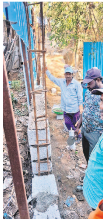
గురుబ్రహ్మనగర్ బస్టిని ఆనుకుని ప్రహారీ నిర్మాణం దృశ్యం
