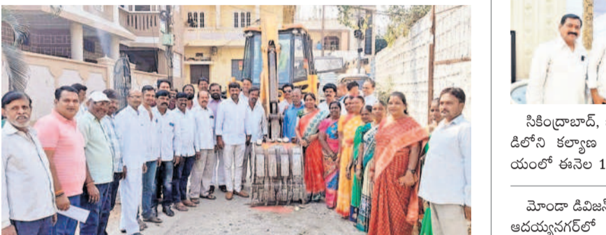
లాల్ గూడలో సీసీరోడ్డు పనులను ప్రారంభిస్తున్న కార్పొరేటర్ ప్రసన్నలక్ష్మి తదితరులు
