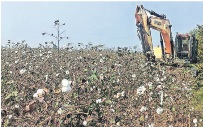
భూపాలపల్లి జిల్లా మహాదేవపూర్ మండలం సూరారం శివారులో వట్టి చేసు మీదుగా ట్రాంట్ పనులను చేపట్టేందుకు అధికారులు సిద్ధం చేసిన జేసీబీ
