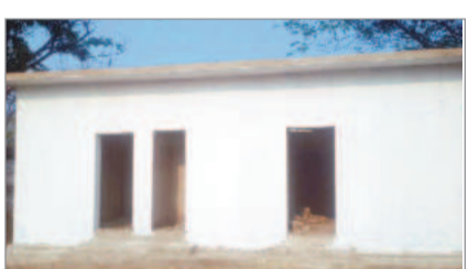
మందమర్రు మార్కెట్ ఆర్టిసీ బస్టాండ్ లో అసంపూర్ణ నిర్మాణంలో ఉన్న పబ్లిక్ టాయిలెట్లు
