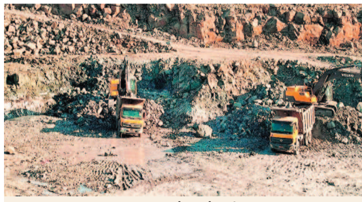
సంగారెడ్డి జిల్లా మనూరు మండలం బోరంపల్లి బసవేశ్వర ఎత్తిపోతల పంపిణీని నిర్మాణం కోసం ప్రారంభమైన భూమి తవ్వకం పనులు
