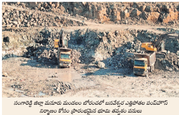
సంగారెడ్డి జిల్లా మనూరు మండలం బోరంపల్లి బసవేశ్వర ఎత్తిపోతల పంపిణీని నిర్మాణం కోసం ప్రారంభమైన భూమి తవ్వకం పనులు
