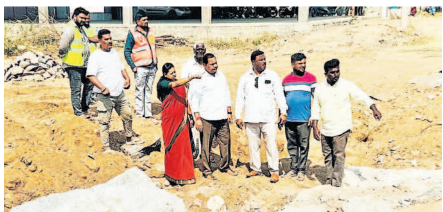
కలెక్టరేట్ పనులను పరిశీలిస్తున్న కార్పొరేటర్ బన్వాల గీతాప్రవీణ్ ముదిరాజ్
