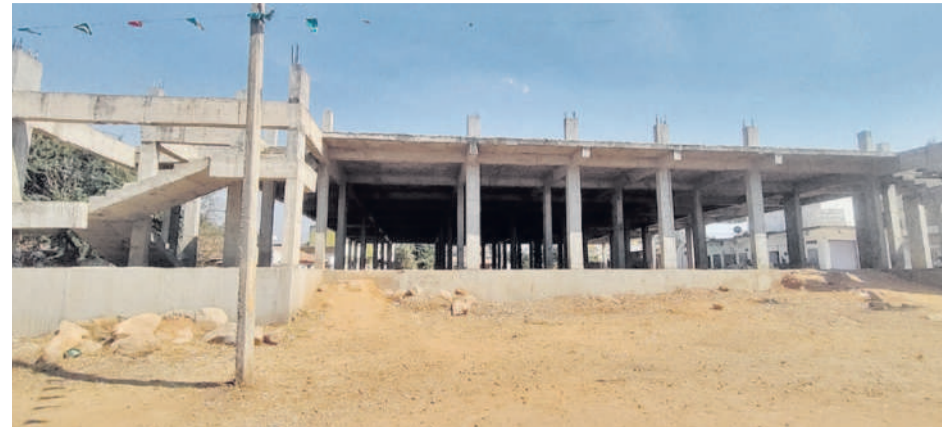
బాన్సువాడలో నిలిచిపోయిన ఇంటిగ్రేడ్డ్ భవన నిర్మాణ పనులు
