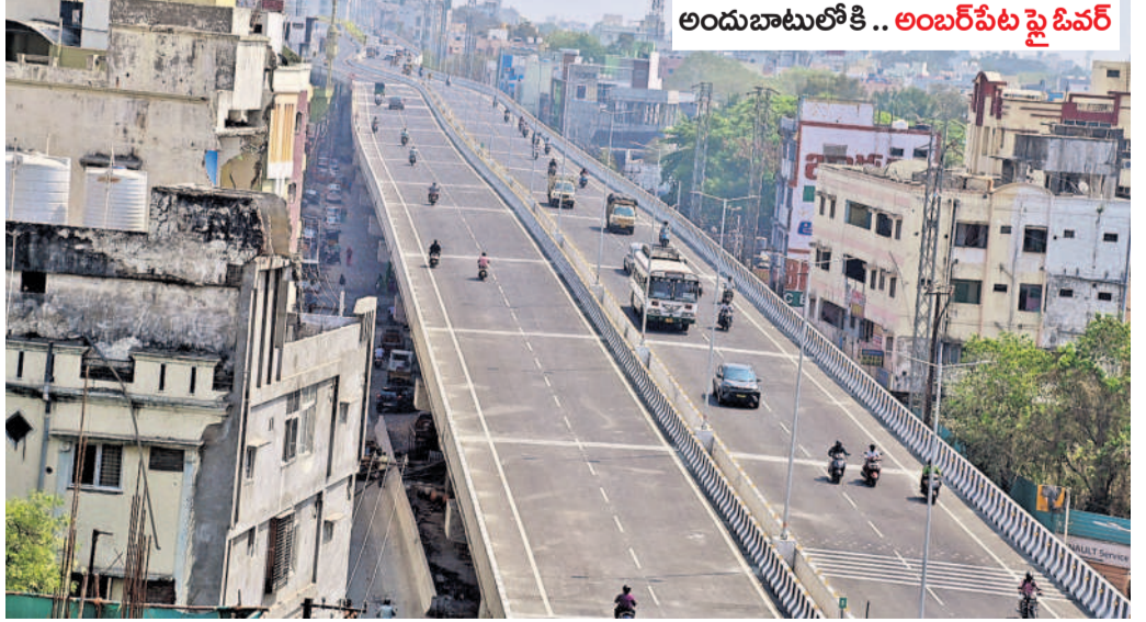
అందుబాటులోకి.. అంబర్పేట ఫై ఓవర్. ఎట్టతేలకు అంబర్పేట నుంచి గోల్కాక వరకు నిర్మించిన ఫై ఓవర్ పనులు పూర్తి అయ్యాయి. దీంతో బుధవారం ఈ ఫై ఓవర్ పై హాహునాలు వెళ్లడం ప్రారంభించారు. బీఆర్ఎస్ హయాంలో ఆ ప్రాంతంలో ట్రాఫిక్ను గుర్తించి రాష్ట్ర తోలి ముఖ్యమంత్రి కేసీఆర్ ఫై ఓవర్ పనులకు శ్రీకారం చుట్టిన విషయం విదితమే..
