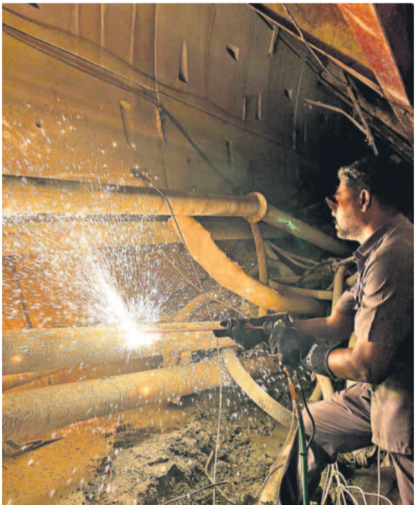
ఎస్ఎల్బీసీ సారంగంలో పైపులను కట్టించే పనులు నిర్వహిస్తున్న నిర్మాణ
