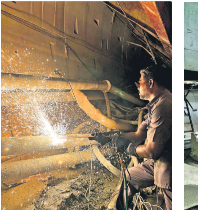
ఎన్ఎల్టీసీ సారంగంలో పైపులను కట్టించే పనులు నిర్వహించి
