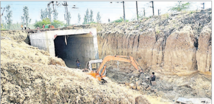
కొనసాగుతున్న అండర్ బ్రడ్జ్ నిర్మాణం పనులు
