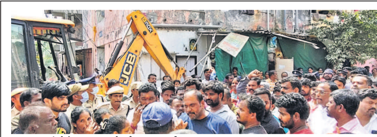
ఇందిరమ్మ కాలనీ లో రోడ్డు పక్కన ఏర్పాటు చేసిన రేకుల గదులను తొలగిస్తున్న హైద్రా అధికారులు.. తమ ఇండ్లను ఎలా కాలుగొడుతారంటూ ప్రశ్నిస్తున్న బాధితులు
