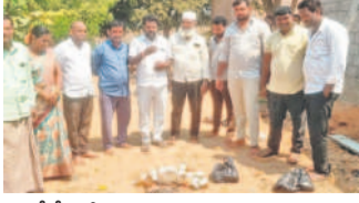
సీసీ రోడ్డు పనులను ప్రారంభిస్తున్న మాజీ చైర్మన్, బీఆర్ఎస్ నాయకులు
