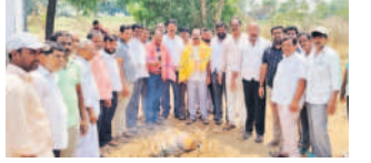
మల్లన్నపల్లిలో సీసీ రోడ్డు పనులను ప్రారంభిస్తున్న అధికారులు
