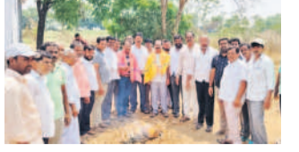
మల్లన్నపల్లిలో సీసీ రోడ్డు పనులను ప్రారంభిస్తున్న అధికారులు
