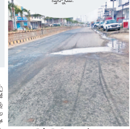
మిషన్ భగీరథ పరిధిలో జాతీయ రహదారిపై లీకేజీలను మిషన్ భగీరథ నీరు
